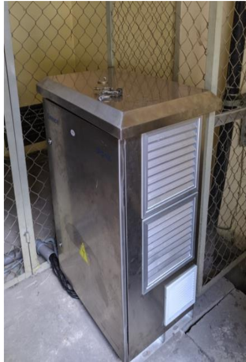
Thiết bị bù và cân bằng pha thông minh Sinexcel tại các trạm biến áp của Điện lực
