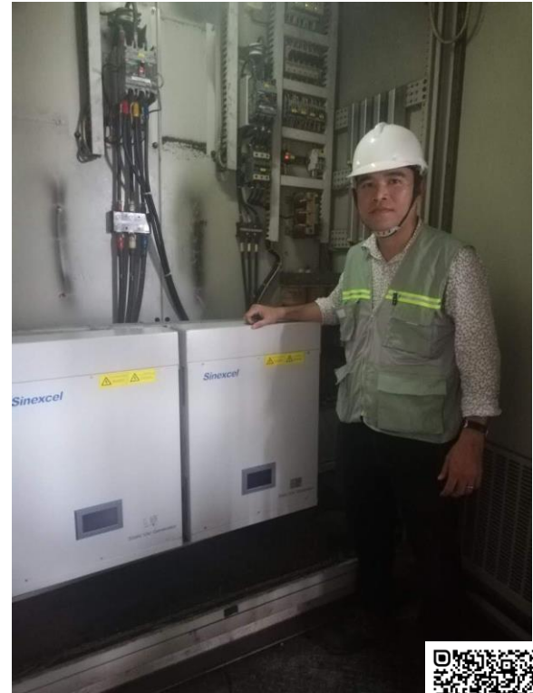
Hệ thống bù vô cấp Sinexcel SVG được lắp hoàn thành và đang chạy
