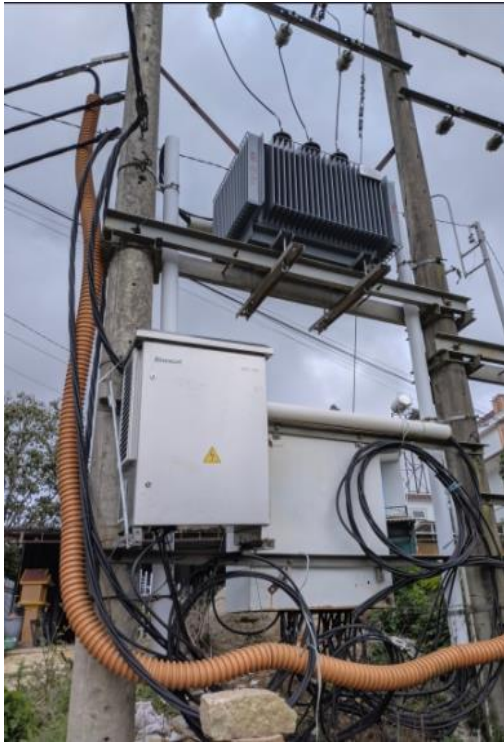
Thiết bị bù và cân bằng pha thông minh Sinexcel tại các trạm biến áp của Điện lực
