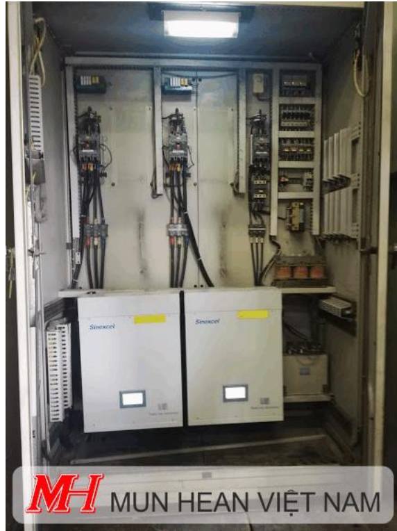
Hệ thống bù vô cấp Sinexcel SVG được lắp hoàn thành và đang chạy
