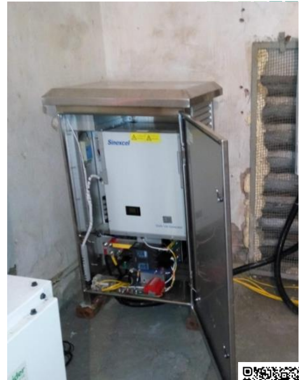
Thiết bị bù và cân bằng pha thông minh Sinexcel tại các trạm biến áp của Điện lực
